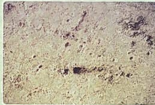
▼局部的損傷・欠損
