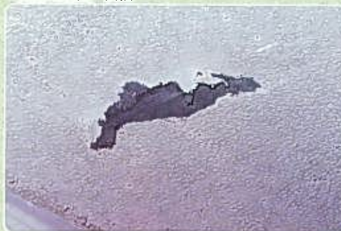
▼局部的損傷・欠損
